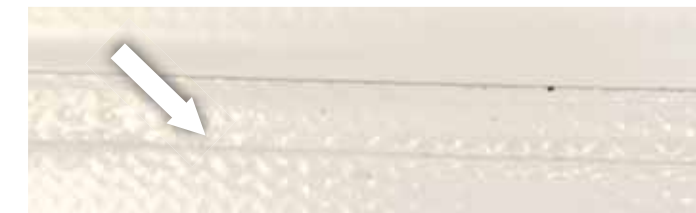
INCORRECTO. EL ARRASTRE DEL TALÓN PUEDE DAÑAR LA MEMBRANA.
